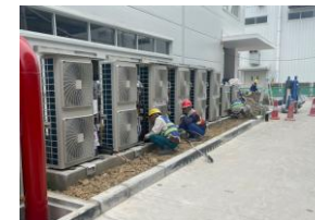
室外機の設置作業
