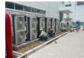
室外機の設置作業
