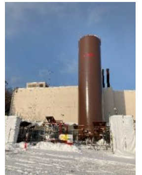
燃料転換(天然ガス化)による脱炭素への貢献
