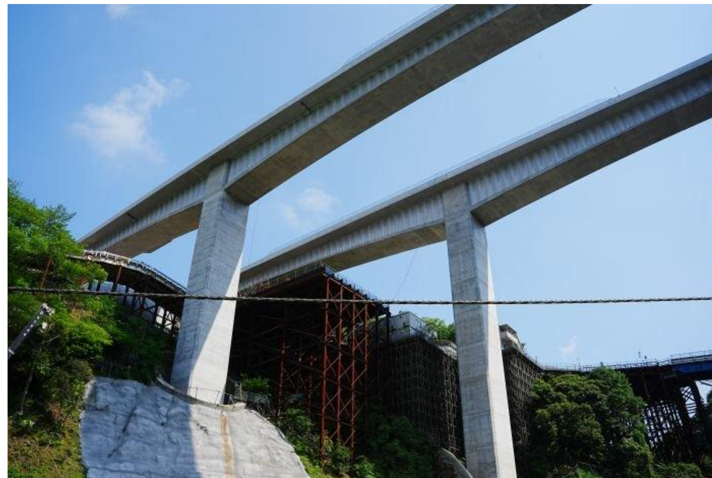
新東名高速道路「新皆瀬川橋」
