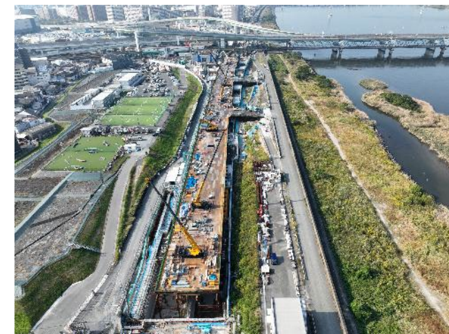
堤防一体型の道路工事に伴うCM
