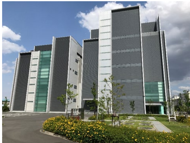
株式会社アイネット第2データセンター
