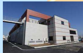
横浜市 川井浄水場 再整備事業
