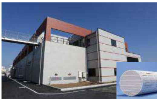
横浜市 川井浄水場 再整備事業
