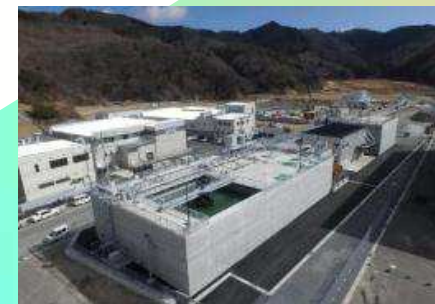
女川町 水産加工団地 排水処理施設整備等事業
