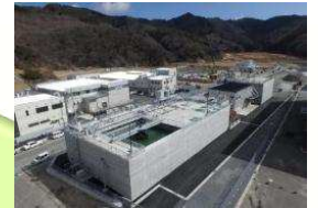
女川町 水産加工団地 排水処理施設整備等事業
