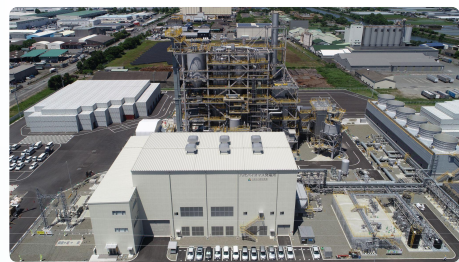
「八代バイオマス発電所」 (2024年6月運転開始)
