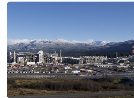
LNGカナダプロジェクト (建設中)
