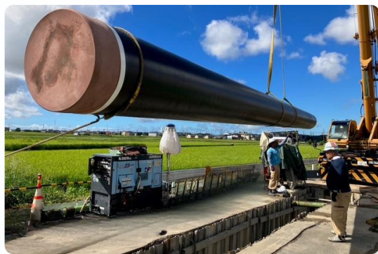
ガス導管の新設工事
