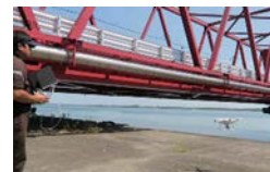
ドローンによる架管点検
