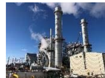
米国フェアビュー火力発電所
