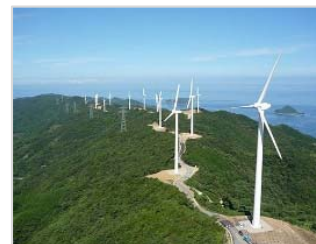
広川明神山風力発電所
