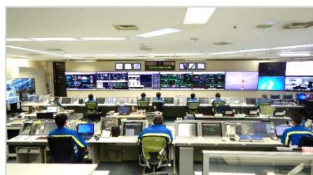
中央制御室（泉北第二工場） ※泉北第一・第二工場を一体的に運転
