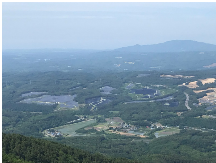
「軽米西ソーラー発電所」全景
