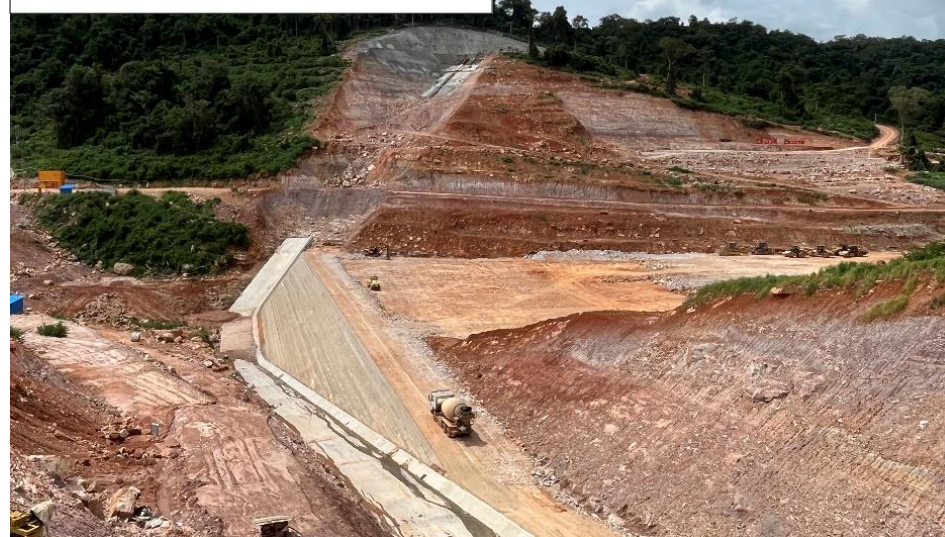
メインダムエリア (南側から撮影)
