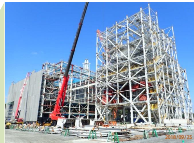
大船渡発電所蒸気ドラム上架式（2018/10月）
