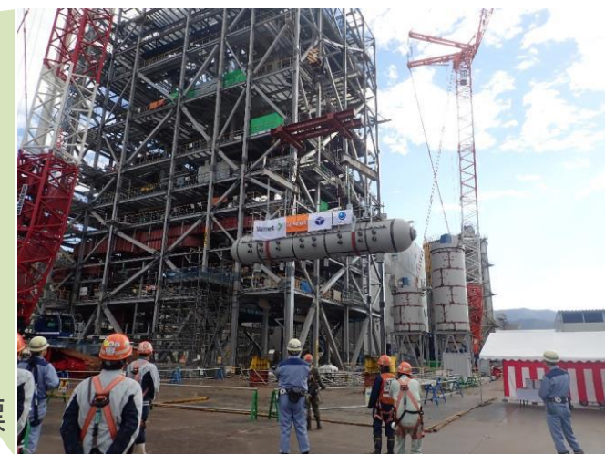
大船渡発電所蒸気ドラム上架式（2018/10月）
