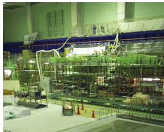
原子炉建屋最上階 工事中の状況
