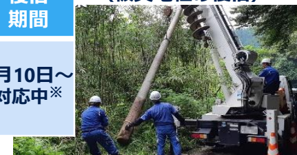
（被災電柱の復旧）
