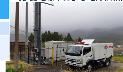
（移動電源車による電力供給）
