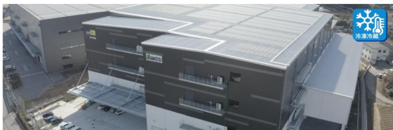
東京主管センター | 延床面積8,300坪 〒352-0005 埼玉県新座市中野1丁目13-7
