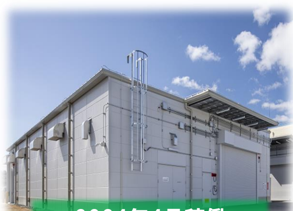
2024年4月稼働 神戸 危険物倉庫
