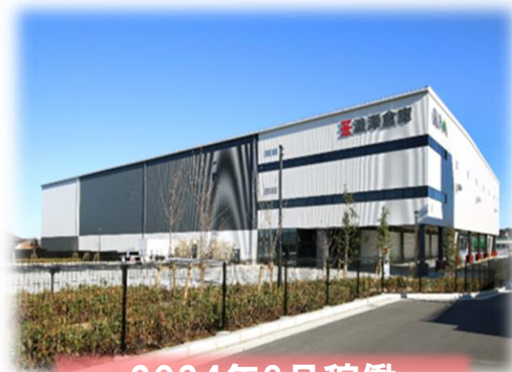
2024年3月稼働 千葉北 第3倉庫
