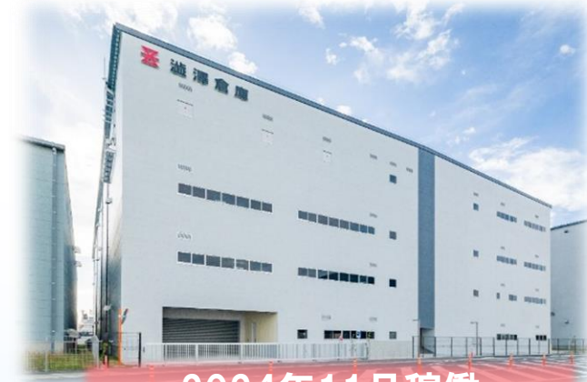
2024年11月稼働 本牧倉庫
