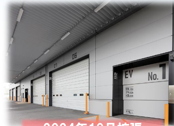
2024年10月拡張 松戸 第3倉庫
