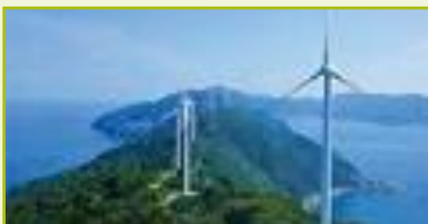
三崎ウインド・パワー (20MW)
