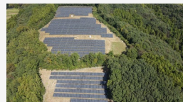
S-59 群馬高崎中室田太陽光発電所
