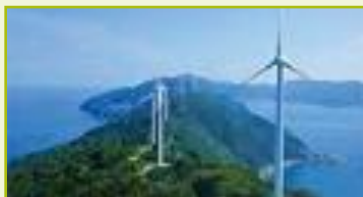
三崎ウインドパワー (20MW)
