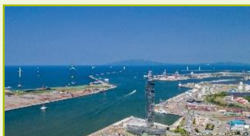
秋田港・能代港洋上風力 (139MW)
