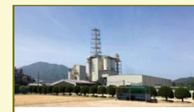
敦賀グリーンパワー (33MW)
