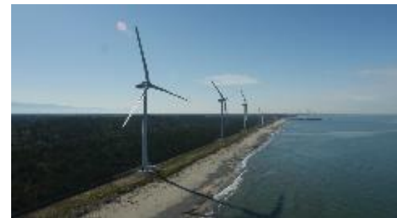
W-01 胎内風力発電所
