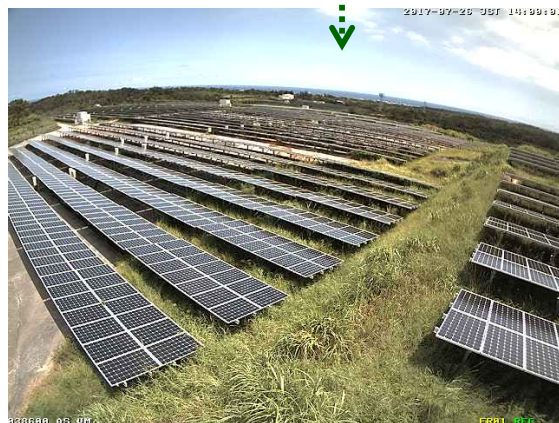
WEBカメラによる発電所の様子
