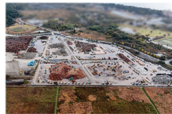
珠洲市 ジャンボリー跡地 [県内最大の仮置場面積:12万m 2 ]
