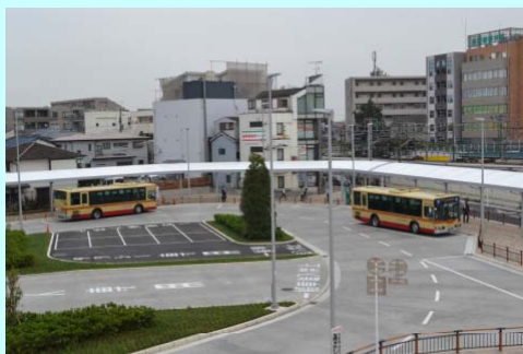
供用を開始した長津田駅北口ロータリー
