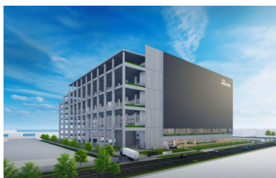
物流倉庫の開発事業 (シンガポール/トウアス地区)
