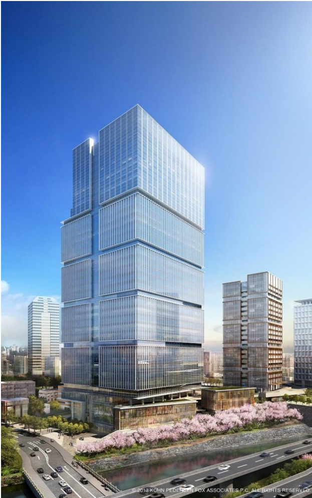
全景（南側より）
