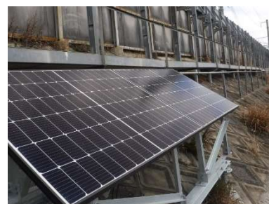
新幹線のり面を活用した太陽光発電（試験設置）
