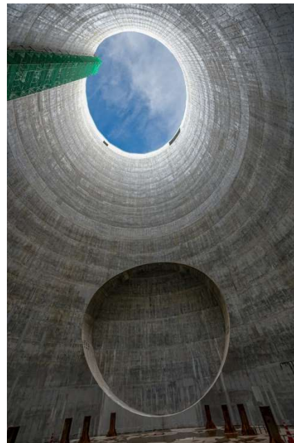
神領非常口 立坑本体の完成
