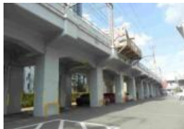
高架橋柱 (曲げ破壊先行型)
