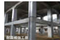
耐震補強工事
