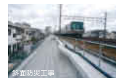
斜面防災工事
