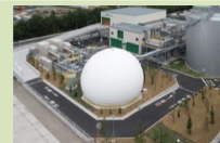
バイオガス(1.8MW)
