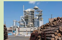
木質バイオマス(12MW)
