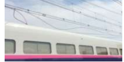
東北新幹線郡山駅構内架線切断
