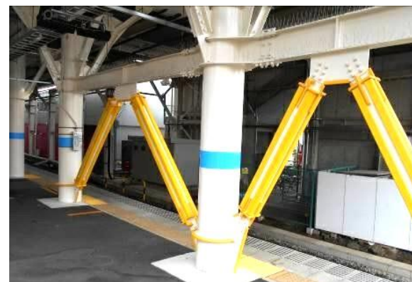
ブレースによる補強（五香駅）
