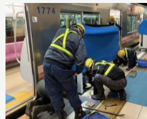
搬入から設置
