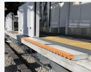
転落防止ゴムの設置 ホームかさ上げ
