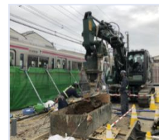
明大前駅付近の工事の様子
