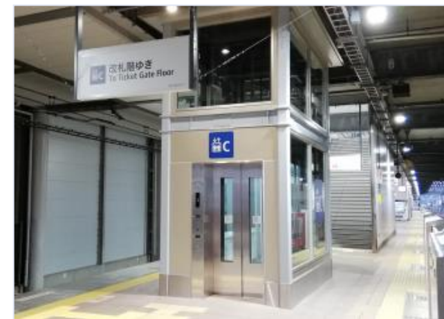
飛田給駅 エレベーター (2019年3月に増設)
