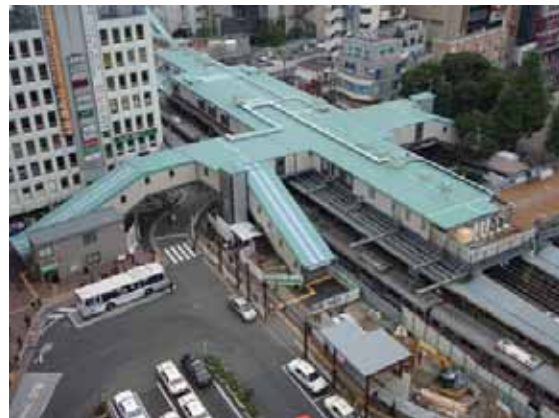
地下化切替前の駅舎
