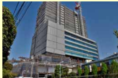
新築工事現場
