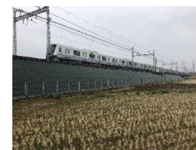
土砂崩壊などの被害を抑制 するために法面を改修
