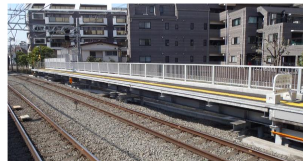
延伸後のホーム (参宮橋駅) Platform after extension (Sangubashi Station)
