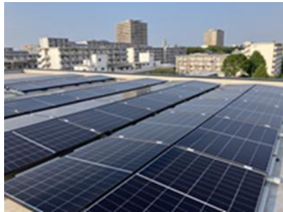
太陽光パネルの設置 (ライブラリ志村坂上)
