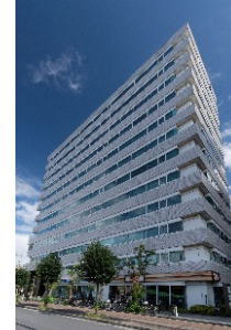
ルーシッドスクエア 新大阪 (大阪府大阪市)
