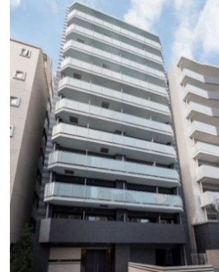
マンション施工事例
