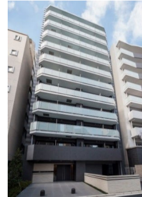
マンション施工事例
