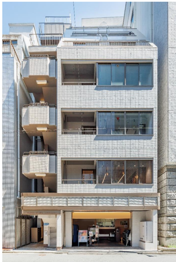
【建物外観(リプランニング後)】 東京都千代田区神田神保町 一棟収益ビル 鉄骨鉄筋コンクリート・鉄筋コンクリート造陸屋根 7階建
