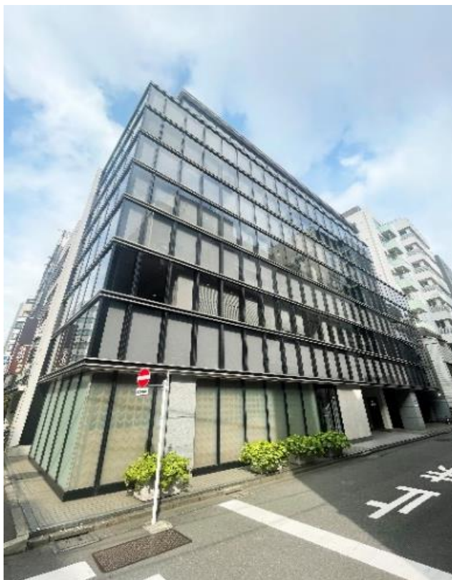
【建物外観(リプランニング後)】 東京都千代田区神田須田町 一棟収益ビル 鉄骨・鉄骨鉄筋コンクリート造陸屋根地下1階付8階建
