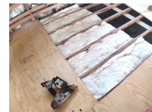
断熱材の設置事例
