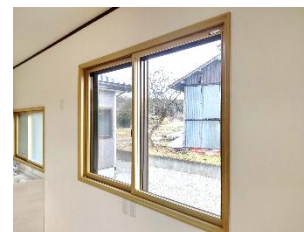
内窓の設置事例
