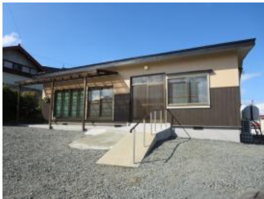
屋根の軒も曲がり、外構も荒れていた平屋の住宅だが、外壁も屋根もこの通りに再生(青森県)
