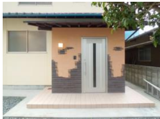
ポーチのタイルを貼りかえ、玄関ドアも新品に交換し、外壁にアクセントタイルを貼付(高知県)
