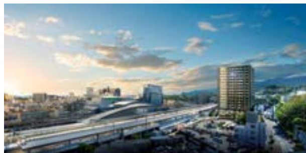
小田原駅前分譲共同ビル マンション建替事業
