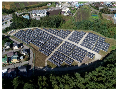
LS長野塩尻発電所
