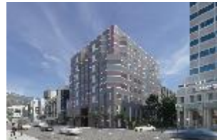
Tower 520 N. Central
