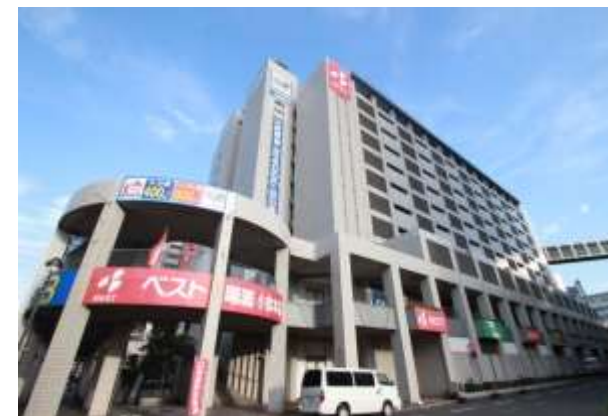
約1,000台の立体自走式駐車場
