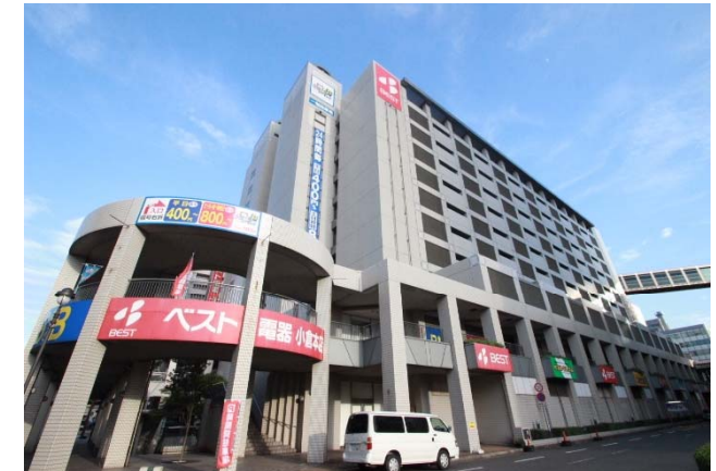
約1,000台の立体自走式駐車場
