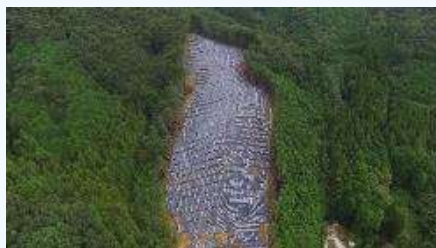
定格出力：1,990kW 取得日：2020年8月
