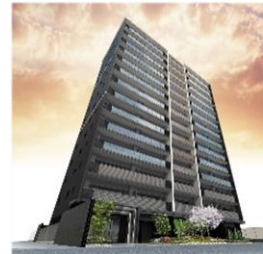
シャルマンフジ和歌山駅ステーションネクスト 14F 65邸 2024年5月29日に完成引渡
